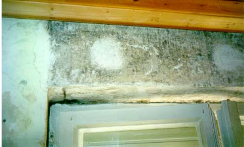
Bild 4 Stockflecken über dem Fenstersturz nach Abnahme einer punktwise verklebten Innendämmung aus gipskartonkaschierten Polystyrol-Hartschaumplatten.
