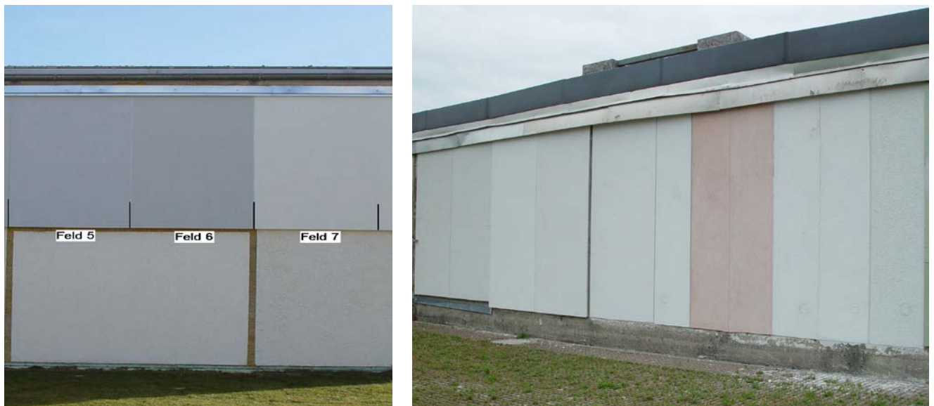
Bild 16 Fotografische Ansicht der westorientierten (rechts) und nordorientierten (links) Fassaden.
