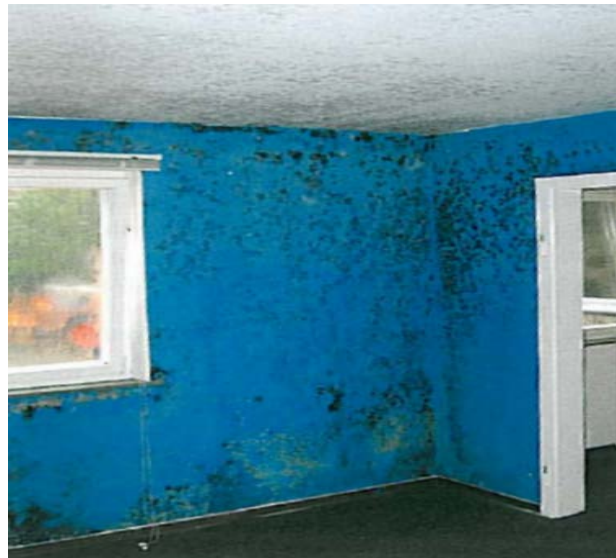
Bild 5 Ansicht eines Raumes ohne eigene Beheizung, temperiert durch Öffnen der Tür zum angrenzenden beheizten Wohnzimmer (Foto: D. Pregizer).
